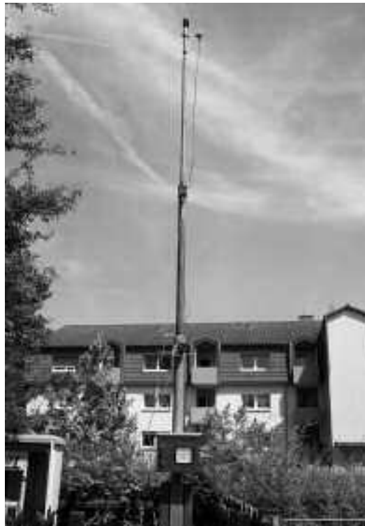
Parallelmessung in Mörfelden-West: Das DFLD-Mikrofon ist unmittelbar neben dem Fraport-Mikrofon am Mast befestigt.
