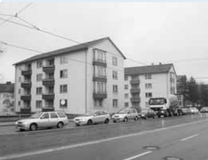
Offene Bauweise an der Weserstraße (ca. 40.000 Fahrzeuge pro Tag). Der Schall wird in die Ruhebereiche (bspw. Balkone) reingetragen. An der Gebäudekante Erdgeschoss wurden zwischen 13.45 und 14 Uhr an einem Werktag 76 Dezibel im Durchschnitt gemessen.
