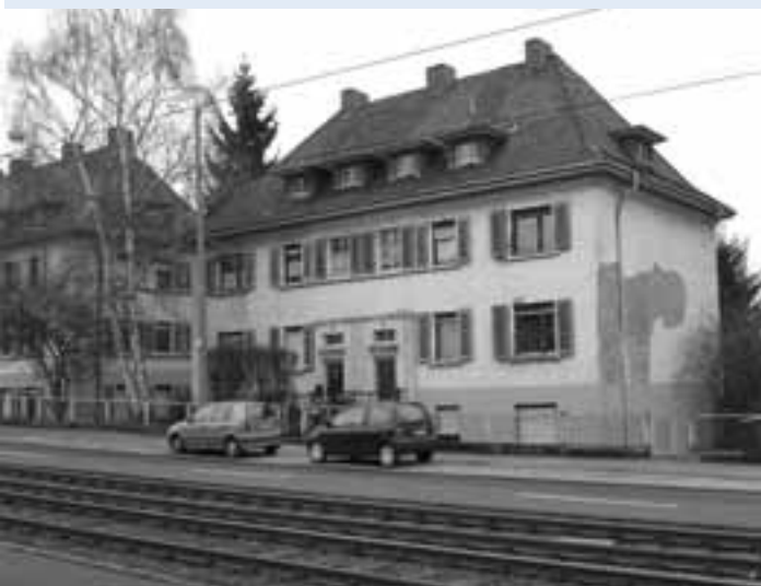
Baulicher Sanierungsbedarf an der Ihringshäuser Straße; auch aufgrund der Lage an einer Hauptverkehrsstraße werden fünf Gebäude gleichen Bautyps nicht saniert
